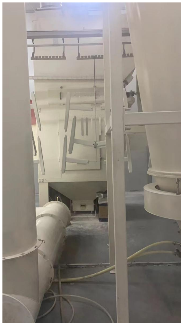
喷粉旋风加布袋除尘器
