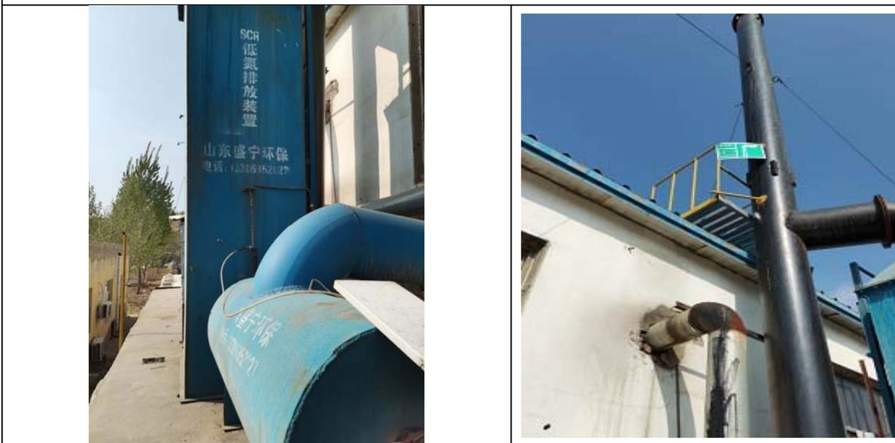
SCR 废气处理设备、采样平台、排气筒
