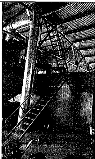
P1 抛丸工序采样平台
