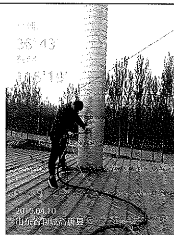
喷塑排气筒 P3 检测孔
