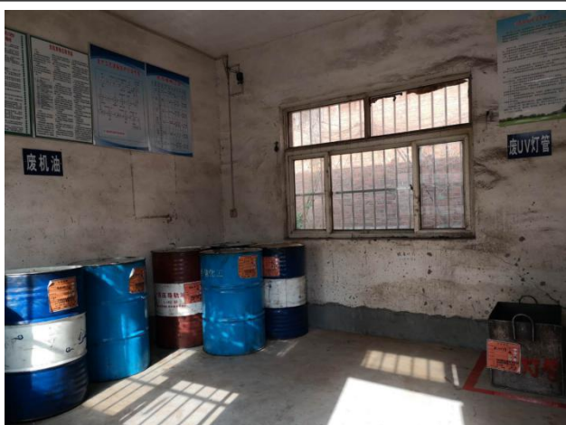
危废间内部防渗
